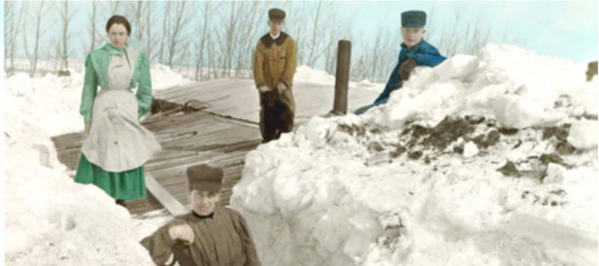
Vintrene i Dakota kunne være forferdelige , snøstormene kunne vare i dagevis . Dette håndfargede bildet fra 1913 viser en familie som står på taket av huset som er dekket av snø , og forsøker å grave huset sitt frem av av snømassene . The Northern Great Plains , 1880-1920: Photographs from the Fred Hultstrand and E.A. Pazandak Photograph Collections .
