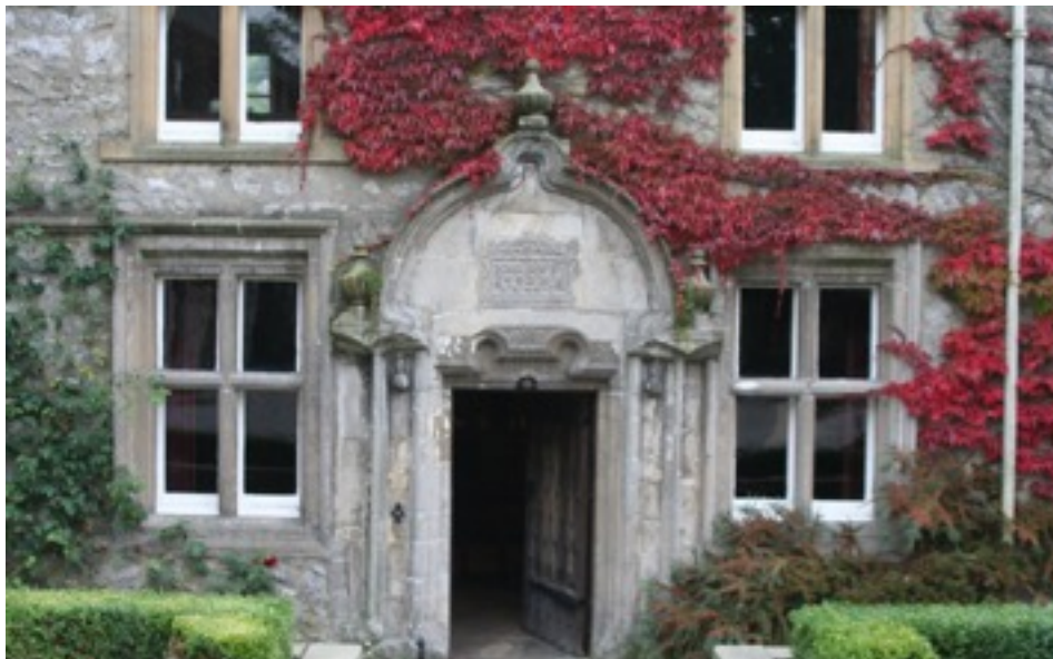
Inngangspartiet til Langcliff Hall
